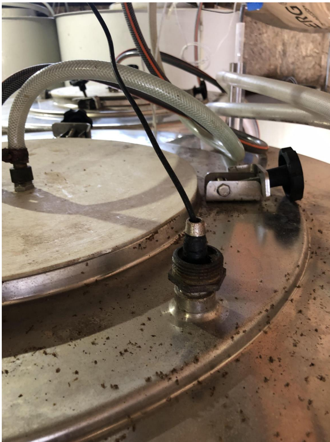
Hordóra szerelt hőmérséklet érzékelő
