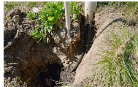
A talajérzékelő telepítése
